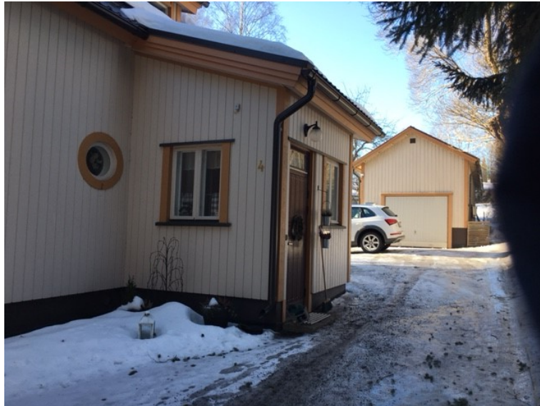
Kuva 3: Näkymä Vaakonkadulta talousrakennukselle. Kuva Tampereen kaupunki.
